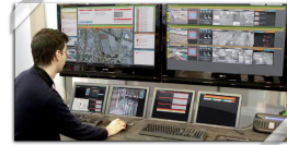
Poste de supervision des flottes de VA
